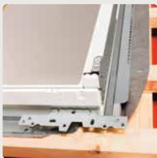
Теплоізоляційний контур надійно утеплює периметр вікна
